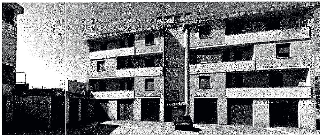
Retro della palazzina con indicato ilgarage
