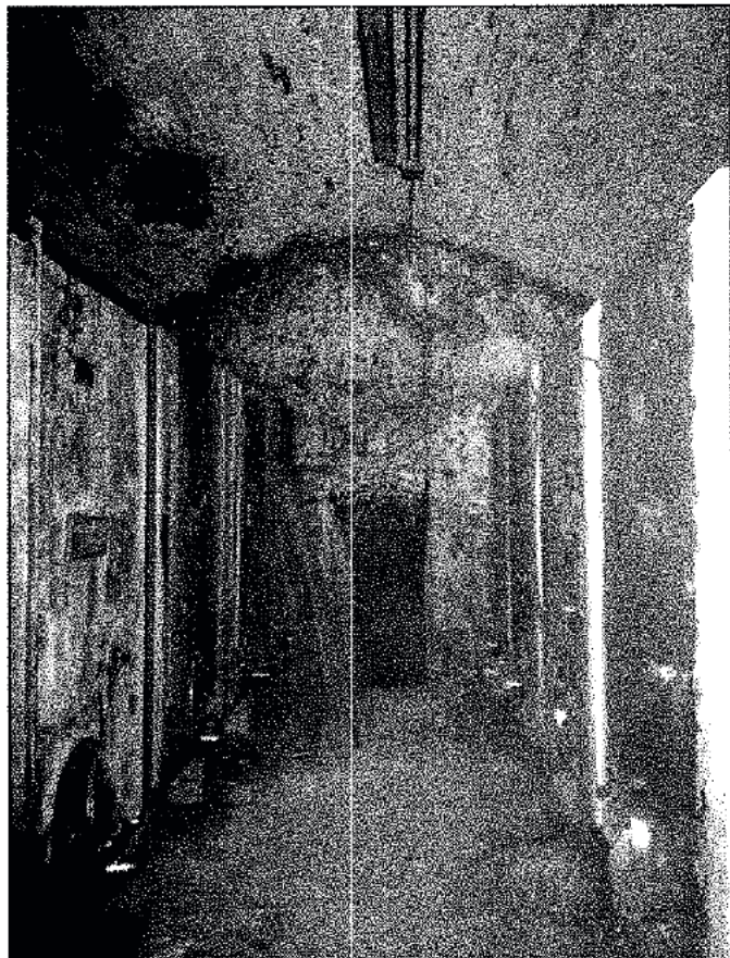
Parete terminale con accesso alla grotta
