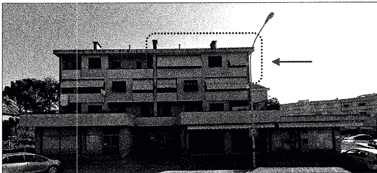
Fronte della palazzina con indicato l'appartamento
