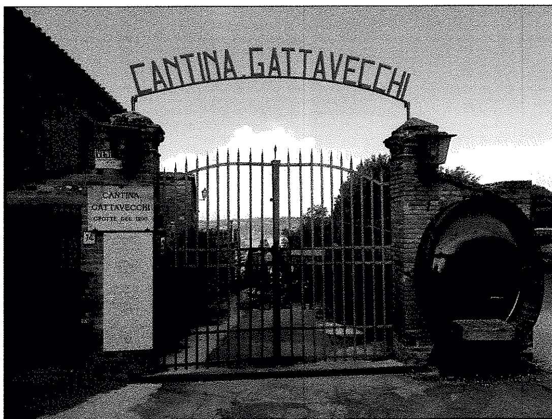
Vista da via di Collazzi dell'entrata
