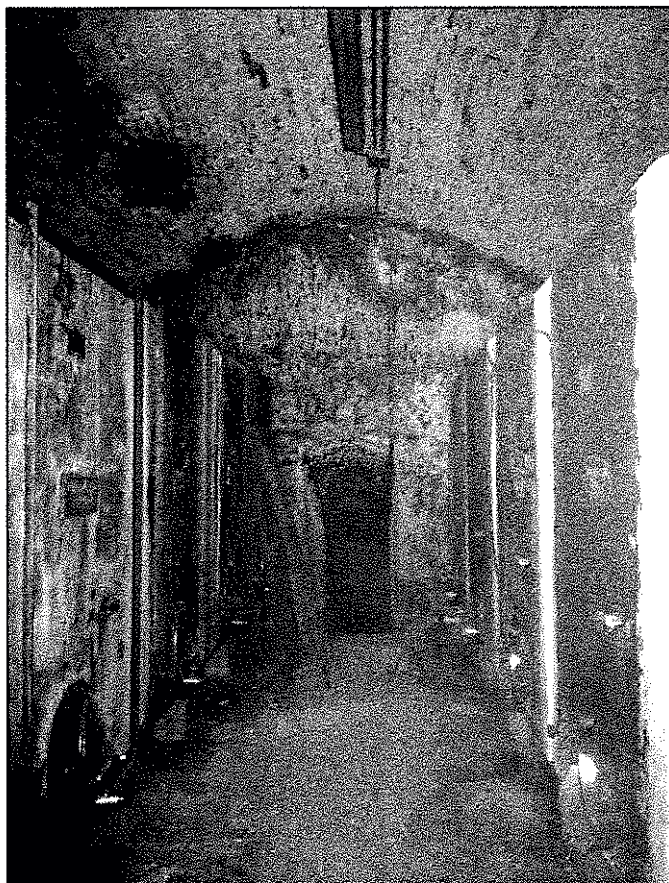
Parete terminale con accesso alla grotta
