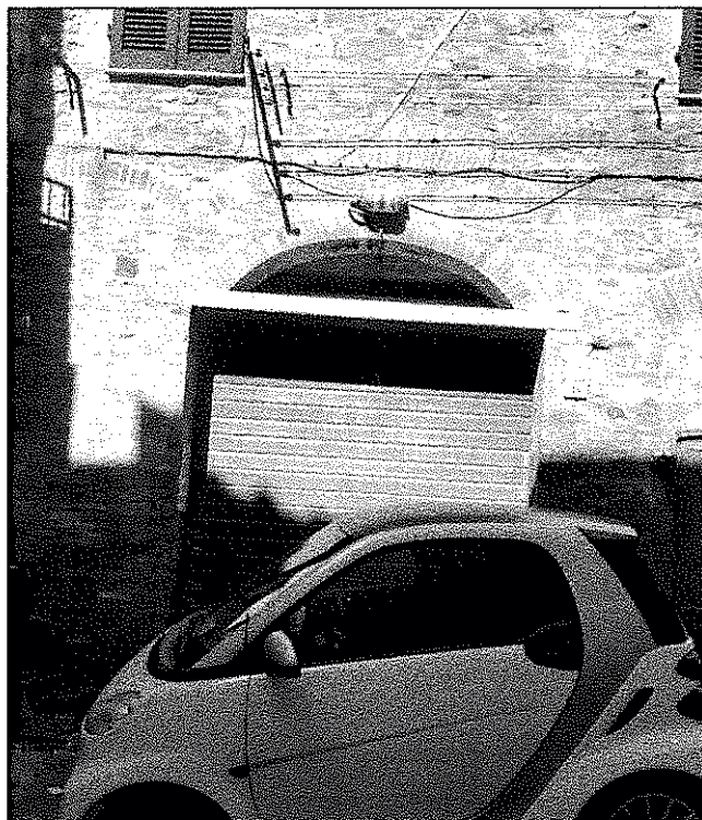
Accesso al magazzino
