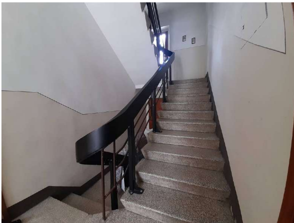
Vano scala condominiale
