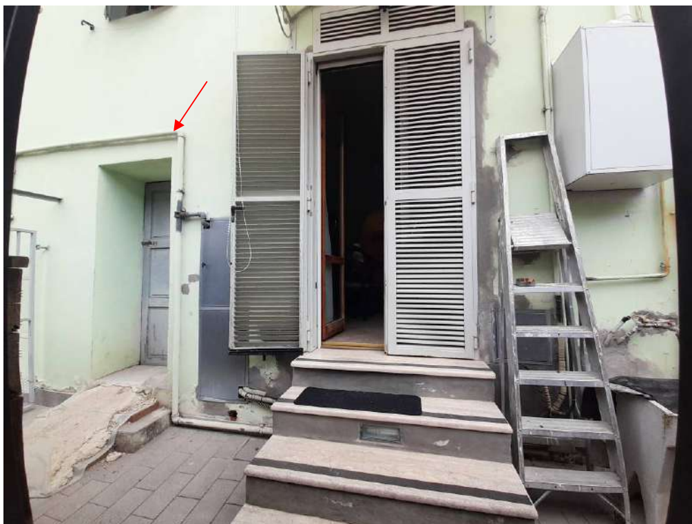
Particolare porta condominiale di servizio sul prospetto sud-ovest
