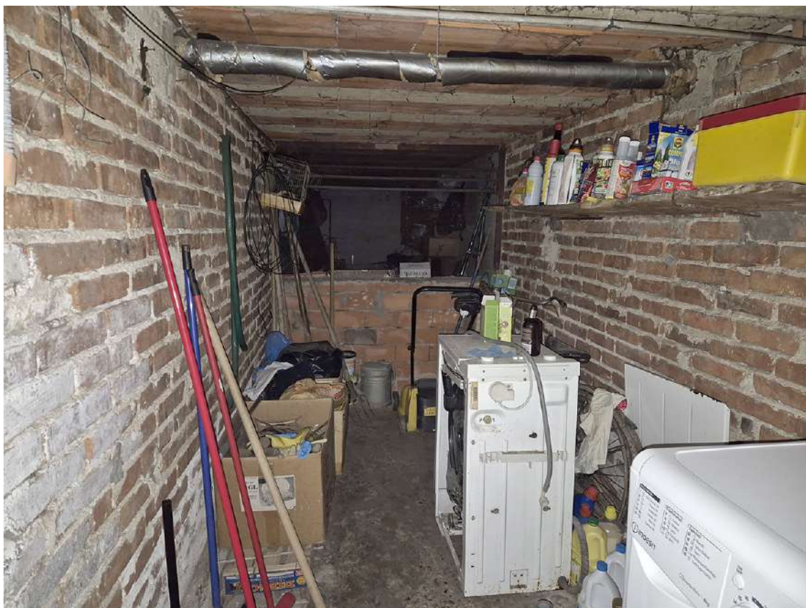
Foto 17: locale a piano seminterrato
