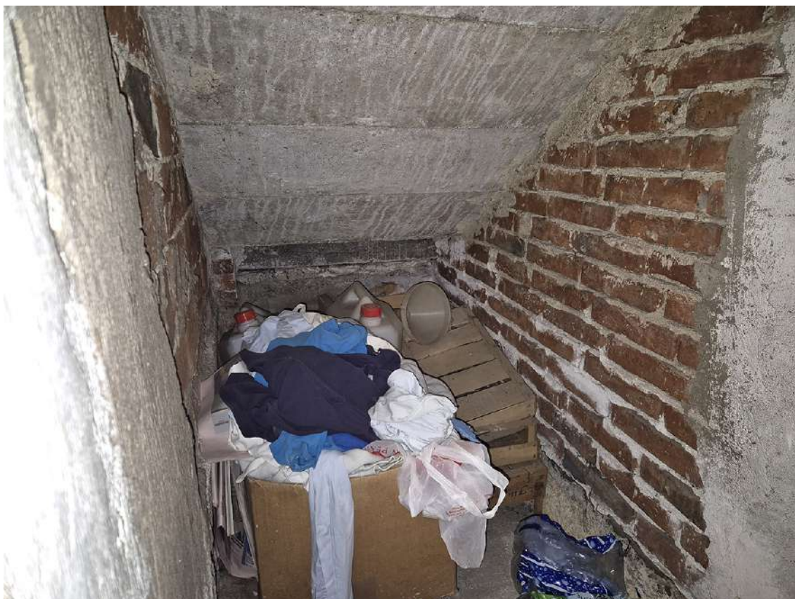
Foto 18: sottoscala a piano seminterrato
