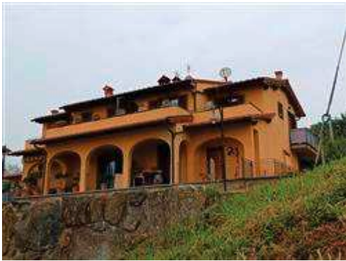
Vedute d'insieme dell'edificio
