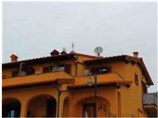
Particolare edificio (appartamento primo piano)
