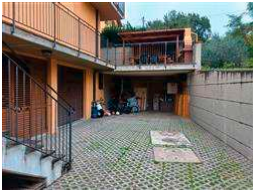
Veduta d'insieme posto auto e piazzale d'accesso
