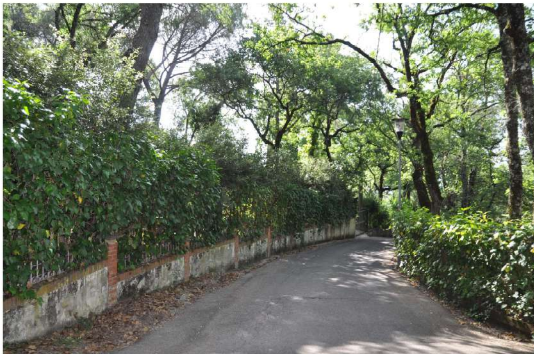
recinzione su via San Quirico
