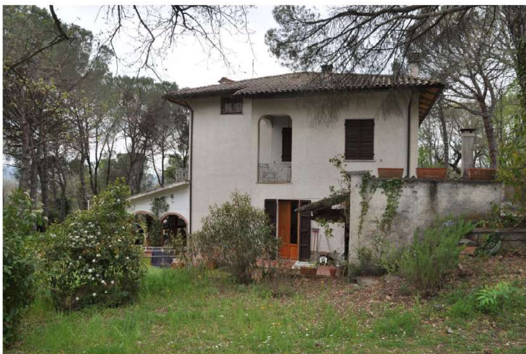
prospetto laterale destro villa e garage
