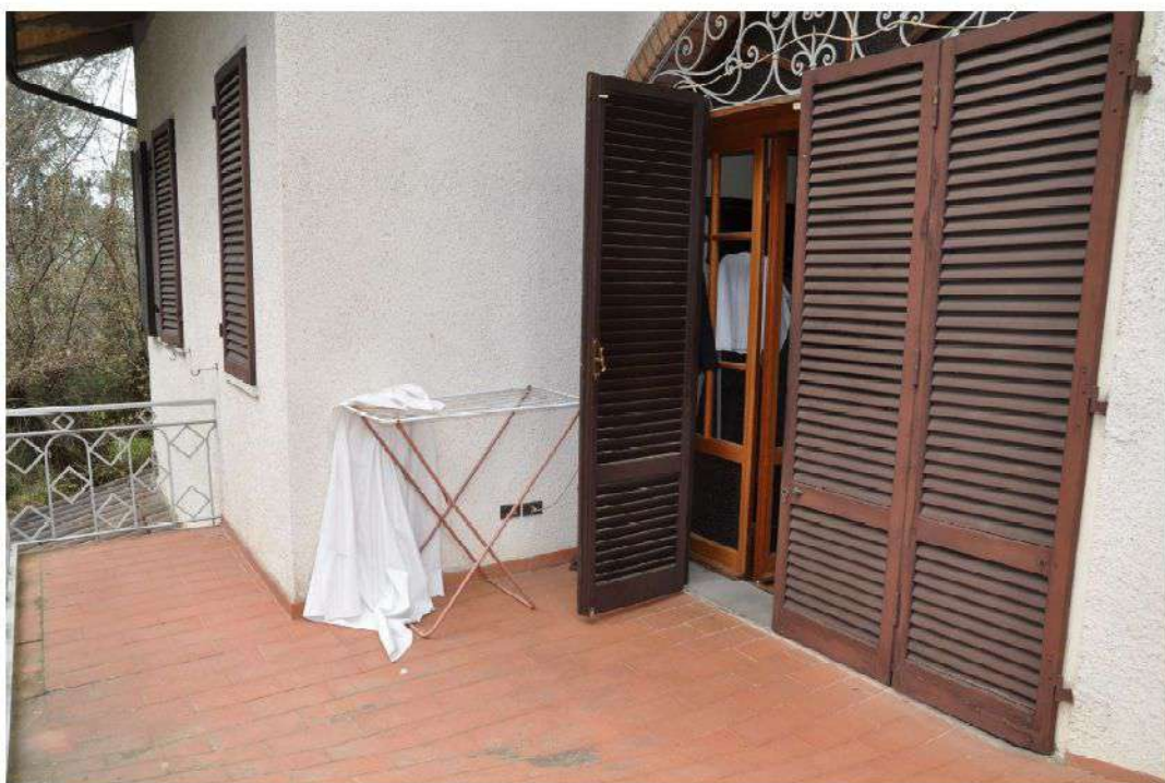
terrazzo sul prospetto principale
