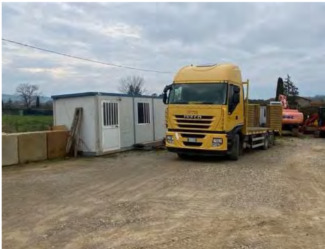
FOTO 3 PART. 1129 (MANUFATTO PREFEBBRICATO)
