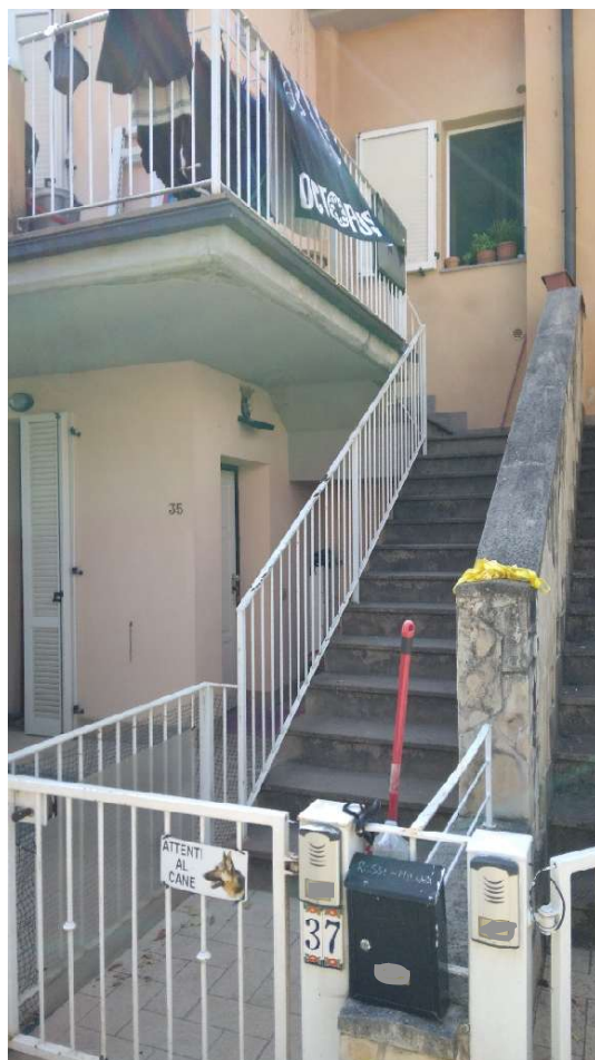
scala di accesso all'appartamento
