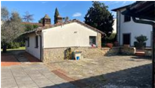
Vista prospetto posteriore
