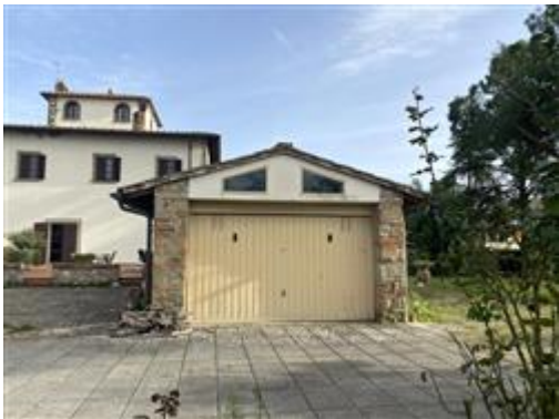
Vista prospetto posteriore
