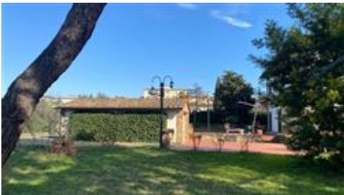
Vista prospetto laterale
