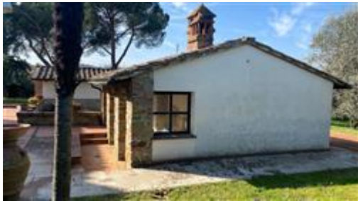
Vista prospetto laterale
