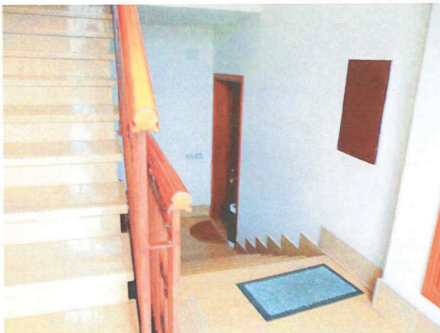
vano scala condominiale
