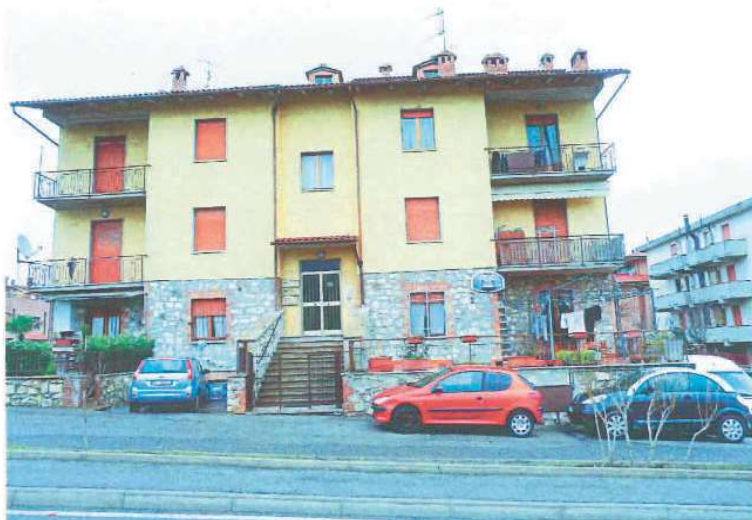
Immobile di Via M. L. King. 29 Pianella – Prospetto frontale
