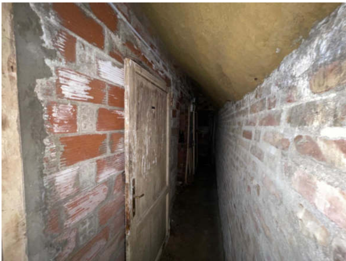
Vista corridoio a comune piano 1s
