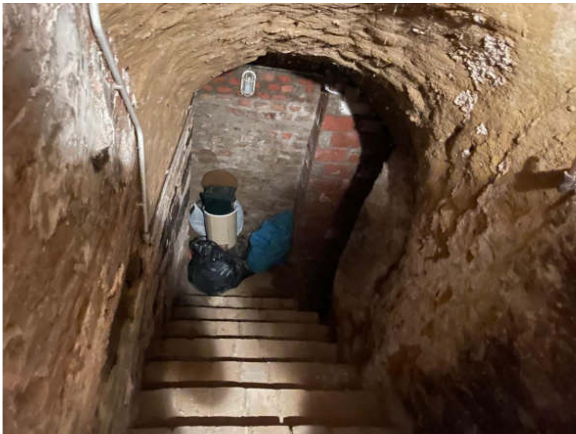
Vista scale di accesso piano 1s dove sono ubicate le cantine
