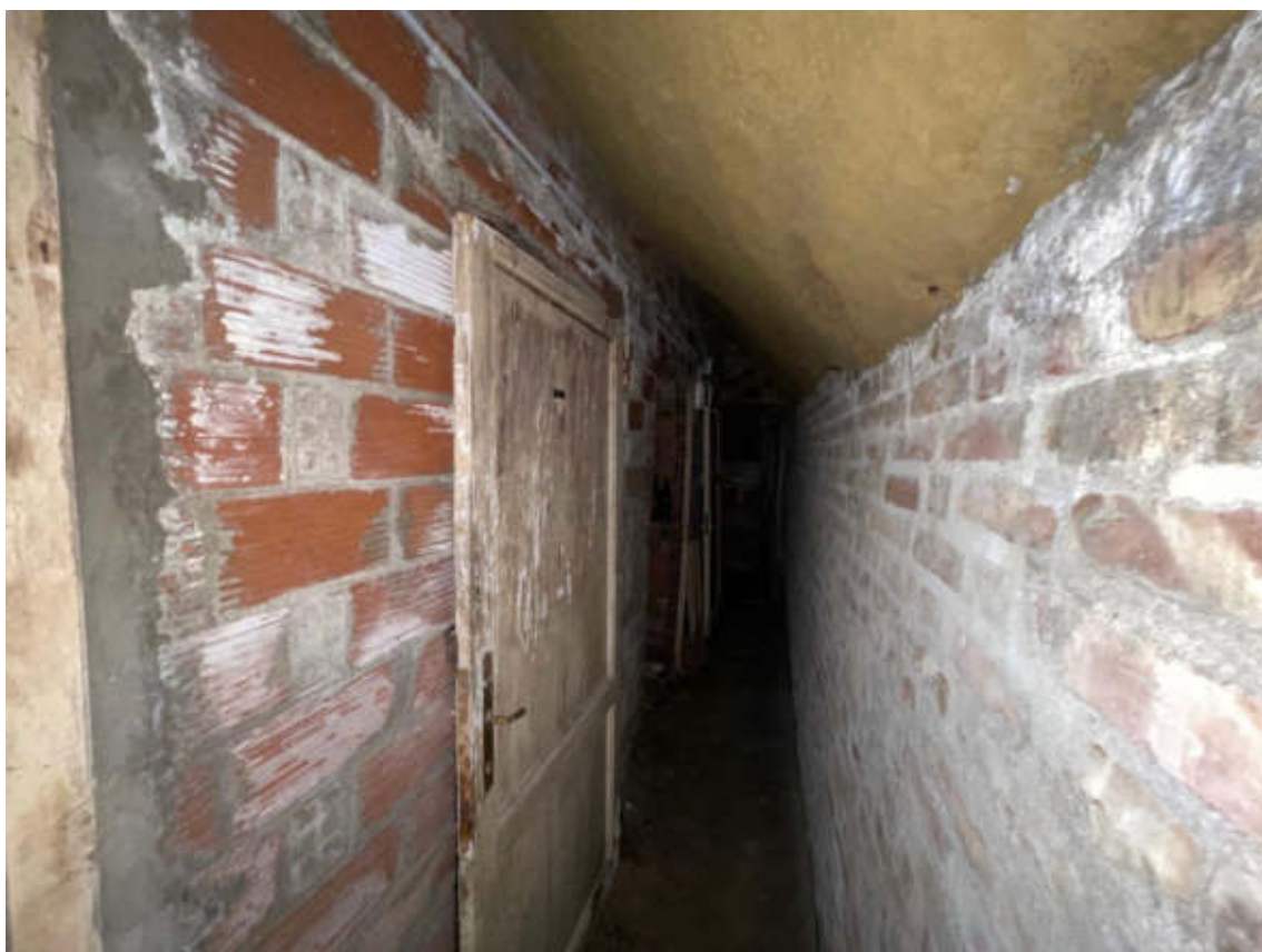
Vista corridoio a comune piano 1s
