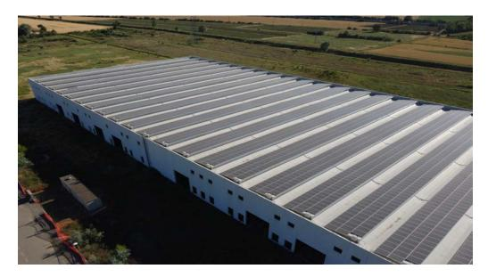
I numerosi pannelli situati sulla copertura sono collegati a degli inverter alloggiati in piccoli locali tecnici realizzati in prossimità dell'edificio principale, ed attualmente identificati dalle particelle 149 e 150.
